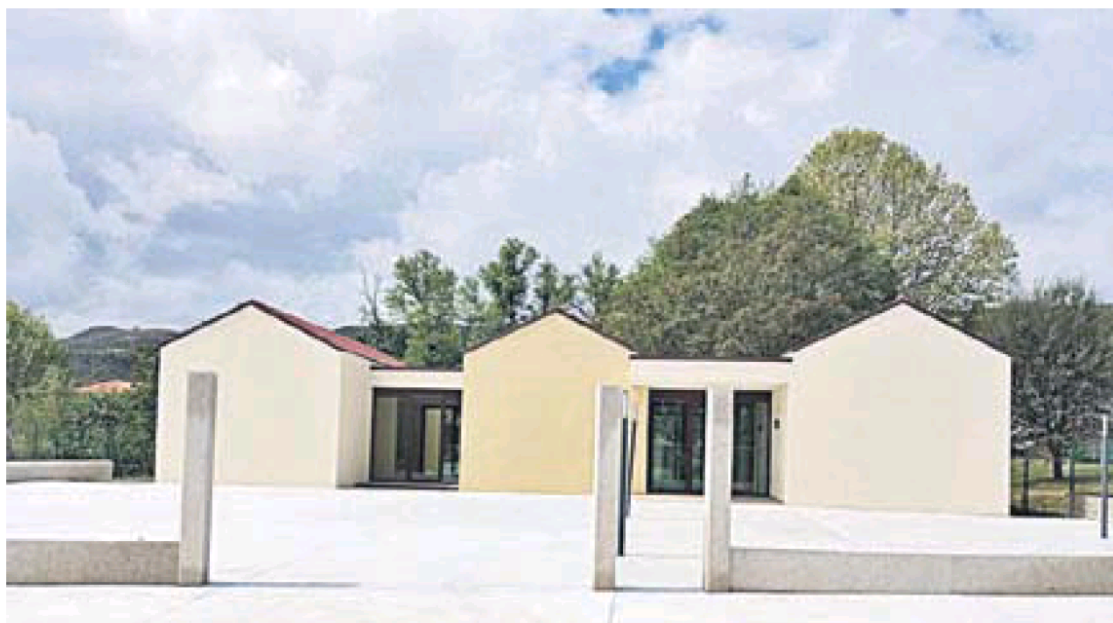
Obras en el edificio que albergará la futura Casa do Maior en el concello de Monterrei.
